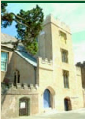
Altes Kloster ganz neu. Kleines Foto: Blick aus dem Fenster des Torhauses. © Torre Abbey
